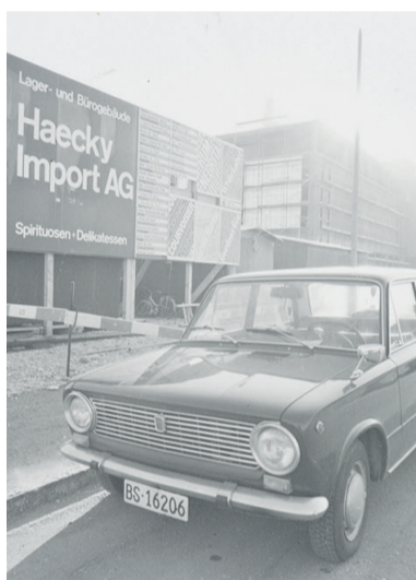
Die Baustelle für den 1973 eingeweihten Haecky-Hauptsitz in Reinach.
